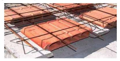
São vergalhões em aço CA 50, que são distribuídos sobre as vigas e amarrados ou entrelaçados nos ferros das vigotas a fim de estabelecer uma amarração entre esses ferros. A colocação desta armação é imprescindível. Nunca concrete uma laje sem a utilização dessas armações.
